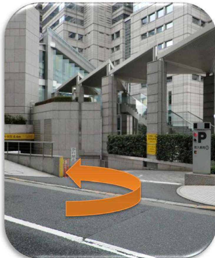
↑ 搬出入駐車場出入口
